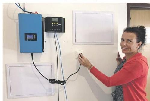
**Jak elektrárna vypadá, jaké má rozměry?** Jak jsem již řekl, existují různé velikosti. Nejoptimálnějším řešením je mikroelektrárna o velikosti 1 kW, což pro vás znamená umístit buď na střeše, nebo na jiném místě 4 panely, a ve vnitřních prostorách pak umístit „mozek“ mikroelektrárny – mikroměnič. To je taková malá krabička, kterou z jedné strany připojíte na instalované panely a z druhé strany do vaší zásuvky. A to je celá instalace. Geniální na těchto mikroelektrárnách je,
