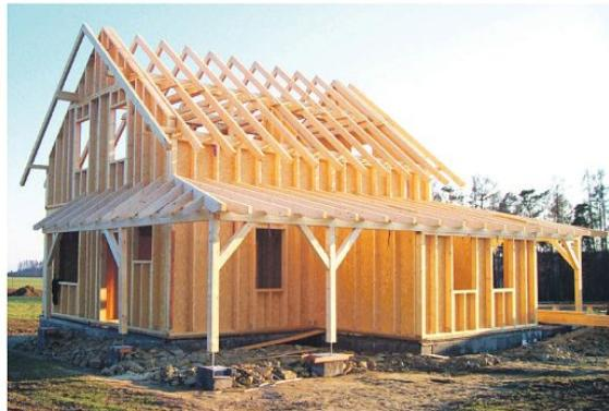
**Dřevostavby** se stále více prosazují na stavebním trhu nejen pro nosné konstrukce rodinných domů, ale také jako nosné konstrukce objektů sportovních a průmyslových hal, jízdáren apod. Mezi nesporné výhody dřevostaveb patří rychlá a nenáročná výstavba, nízká spotřeba energie na vytápění a díky používání materiálů z obnovitelných zdrojů je také stavba velice ekologická.
